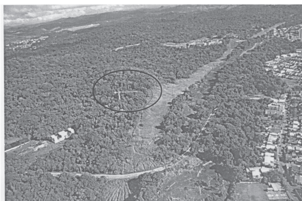
Figura 1. Vista aérea del sitio de la grúa instalada en el Parque Natural Metropolitano, costa del Pacífico, Panamá.
